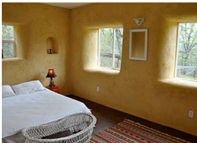
De l'argile pour plafonner les murs
