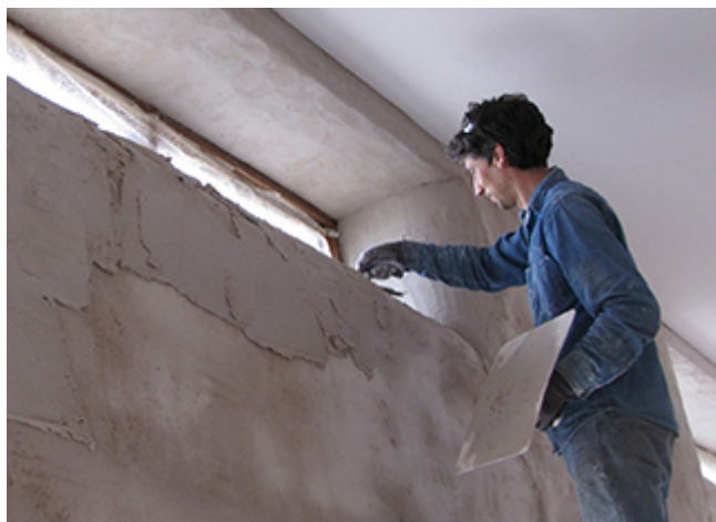
Plafonner avec de la chaux
