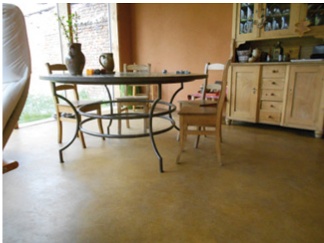
Dalle en terre battue Etienne Guillaume, Elémenterre
