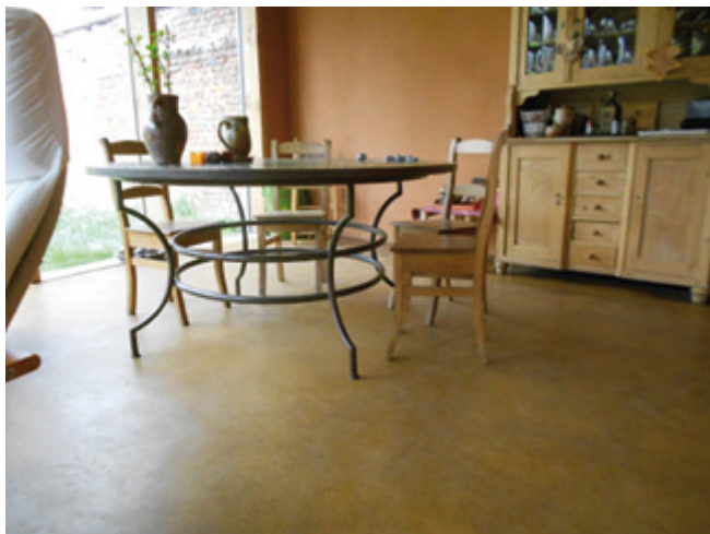
Dalle en terre battue Etienne Guillaume, Elémenterre
