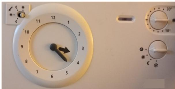
Le thermostat programmable permet de définir les périodes de chauffe et les périodes de ralenti. On peut par exemple chauffer à 19°C
