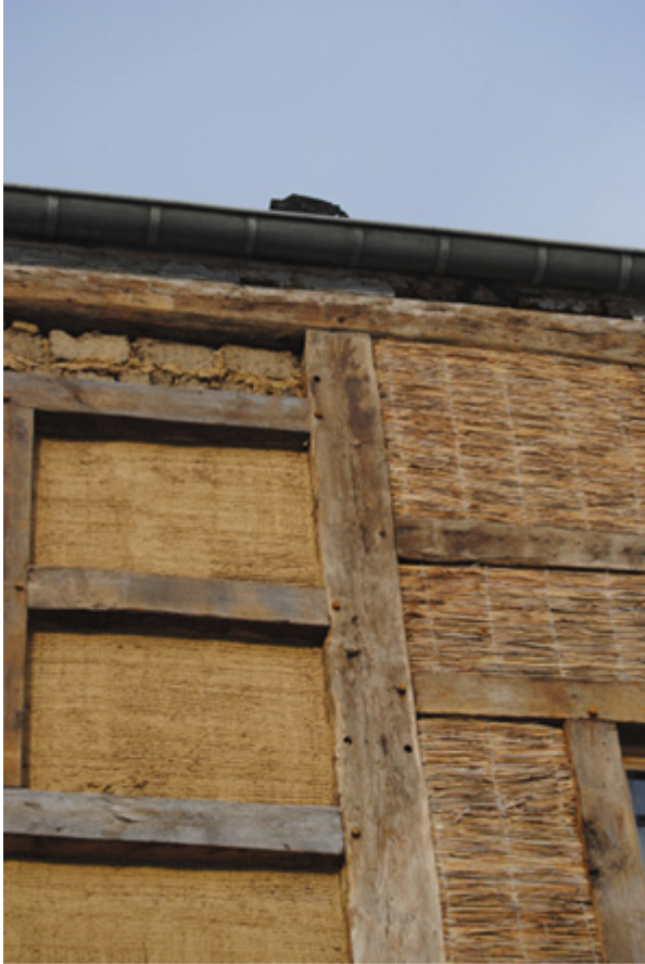
Façade en restauration en colombage et torchis. Source : Sophie Bronchart – produits Claytec
